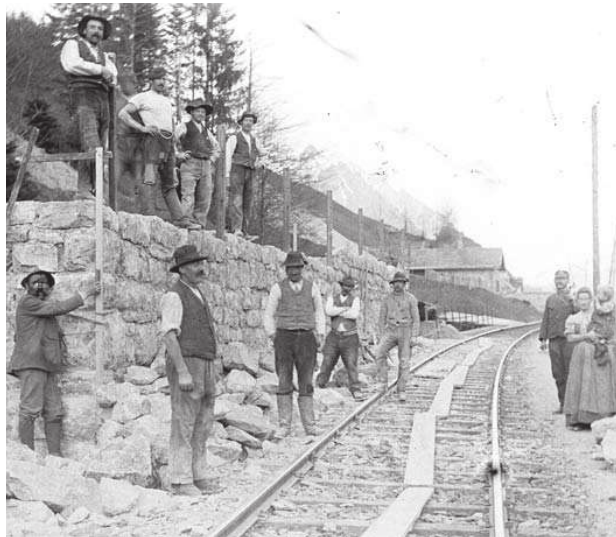
Arbeiter an der Arlbergbahn.
